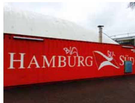
Der Technikcontainer und Sommerhaus der Tennisblase
